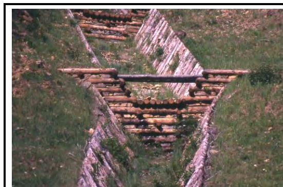
Fig. 1.63 - Esempio di briglia realizzata con le tecniche dell'ingegneria naturalistica. Si tratta di una struttura a scarso impatto paesaggistico.
