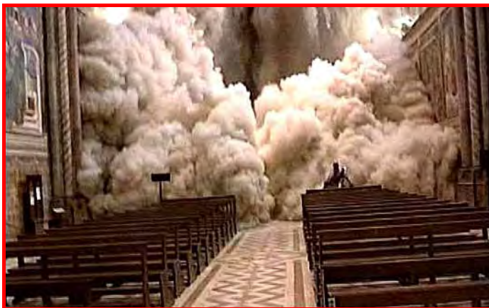
Crollo del tetto della basilica di S. Francesco durante il terremoto di Umbria e Marche del 1987, con magnitudo magnitudo 6,1 della scala Richter registrato il 26 settembre.
