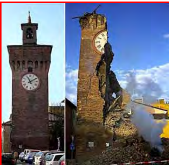
La Torre dei modenesi di Finale Emilia prima e dopo il terremoto dell'Emilia del 2012. Magnitudo 6,1 della scala Richter registrato il 20 maggio.
