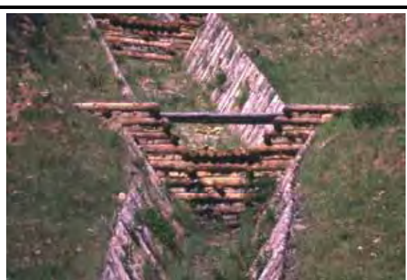
Fig. 1.63 - Esempio di briglia realizzata con le tecniche dell'ingegneria naturalistica. Si tratta evidentemente di una struttura a scarso impatto paesaggistico.
