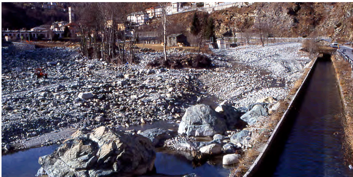
Lo Stura di Lanzo, presso Pessinetto, in pieno inverno, risulta con alveo pressochè prosciugato, mentre il canale derivatore per fini idroelettrici (ENEL) è colmo d'acqua.
